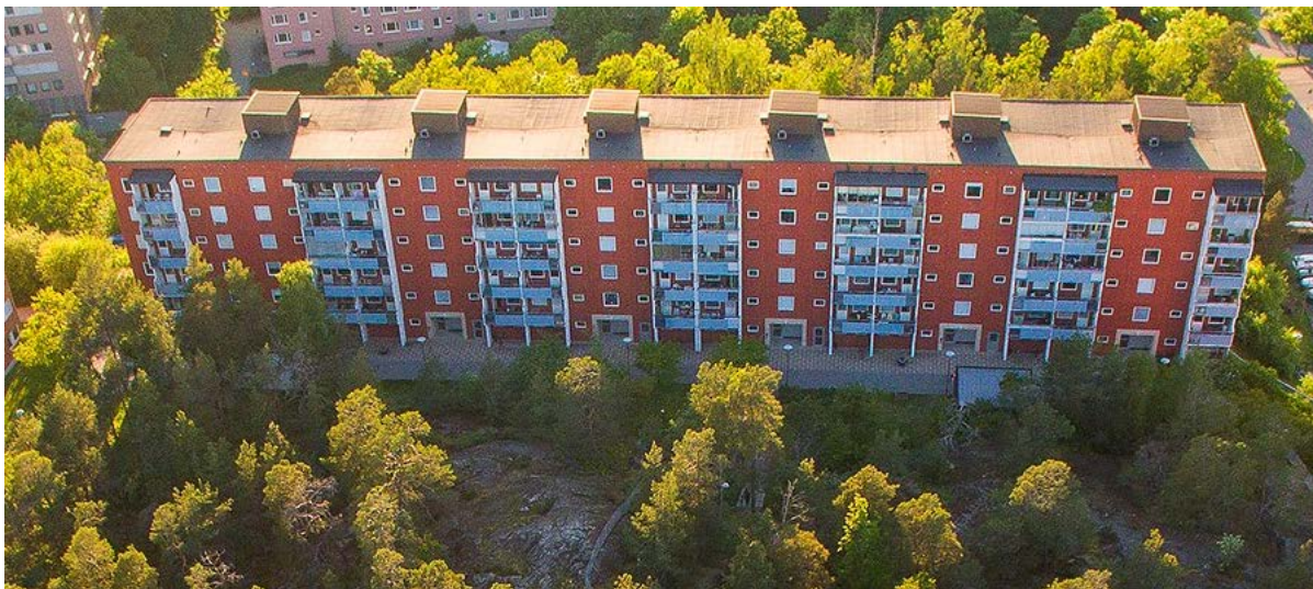
Lilla Stavangergården, Stavangergatan 4-16
