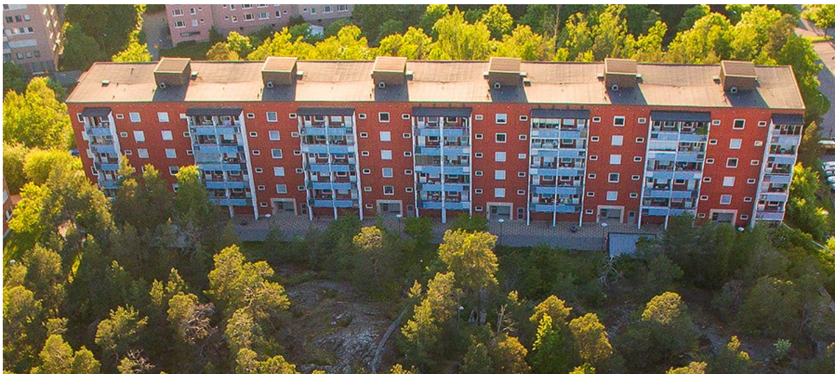
Lilla Stavangergården, Stavangergatan 4-16
